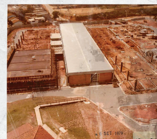
Construção da fábrica da SEMIKRON em Carapicuíba, São Paulo em 1979
